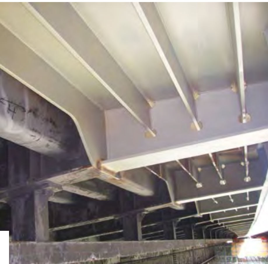
Nové rozšíření mostovky (stav srpen 2019)
