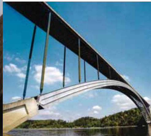
Snímky pod sebou: Most Žďákov Ložisko oblouku a betonová konzola Rekonstrukce levobřežní opěry
