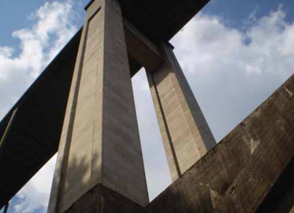
Most Žďákov – pylon na patce oblouku
