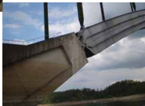
Most Žďákov – pylon na patce oblouku
