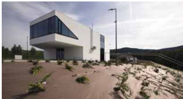
Prosklení severovýchodní fasády Technologického centra připomíná čelní sklo automobilu s výhledem do krajiny
