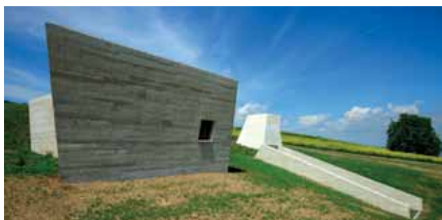
Ze země vykukují nepravidelné věže se šikmými stěnami z betonu
