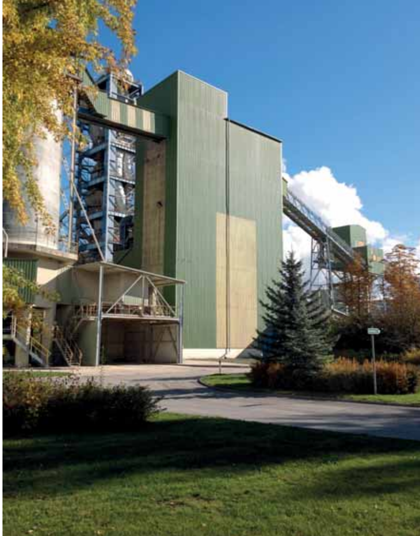
Výrobní linka odsiřovacího vápence ENVICALC v Čížkovicích
