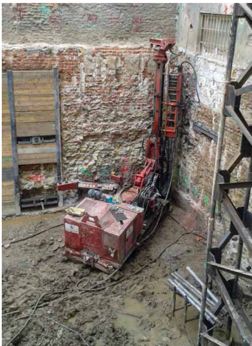
Trysková injektáž na místě stavby
