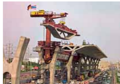
Expressway Bangkok, montáž segmentů
