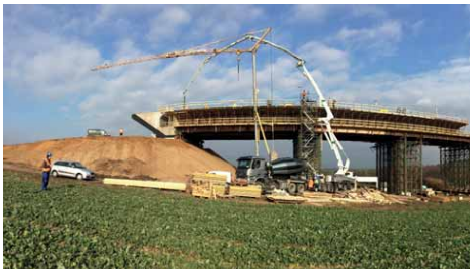
Předpětí nosné konstrukce mostu je realizováno pomocí 19 lan o průměru 15,7–1640/1860
