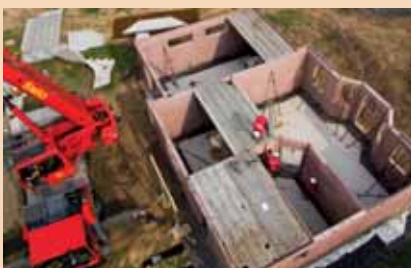
Montáž stropních dílců, pokládka vrchní výztuže stropu
