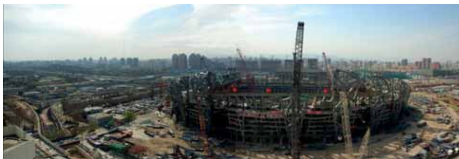
Celkový pohled na rozestavěný stadion (2006)
