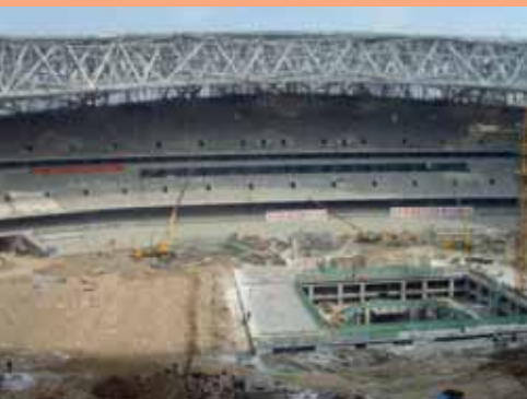
Stavební práce na sportovní ploše (2007); tribuny z prefabrikovaného betonu, nad nimi fasáda z ocelových žeber
