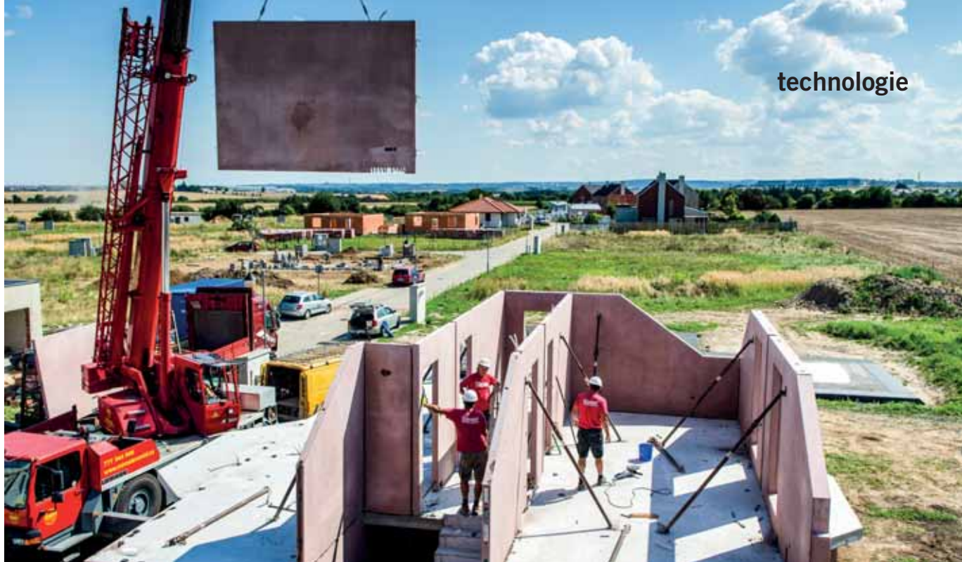
Montáž stěn 2. NP během třetího dne na stavbě
