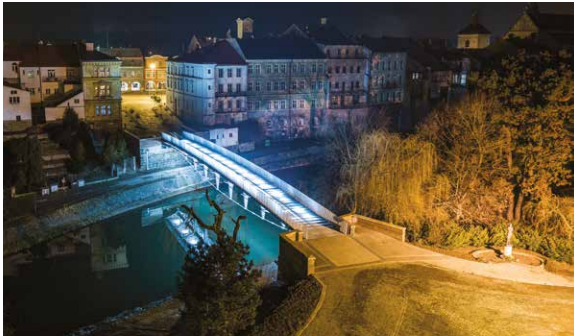
Celkový snímek mostu při nočním osvětlení
