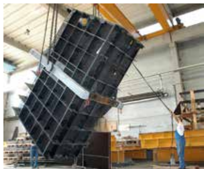
Betonové stély s ocelovou kostrou vyrobila firma Geithner Bau, 2003
