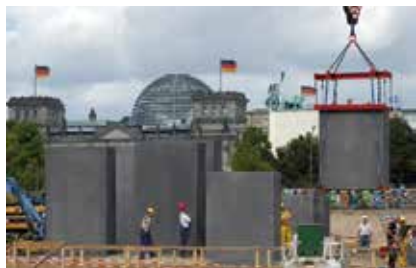
Usazování betonových bloků, v pozadí Braniborská brána a kupole Reichstagu, 2005
