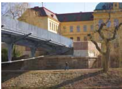
Pravobřežní opěra po rekonstrukci
