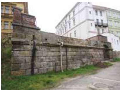
Původní stav levobřežní opěry
