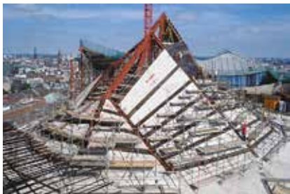
Střechu hlavního koncertního sálu se podařilo usadit, 2011 (foto: © Hochtief, AG)
