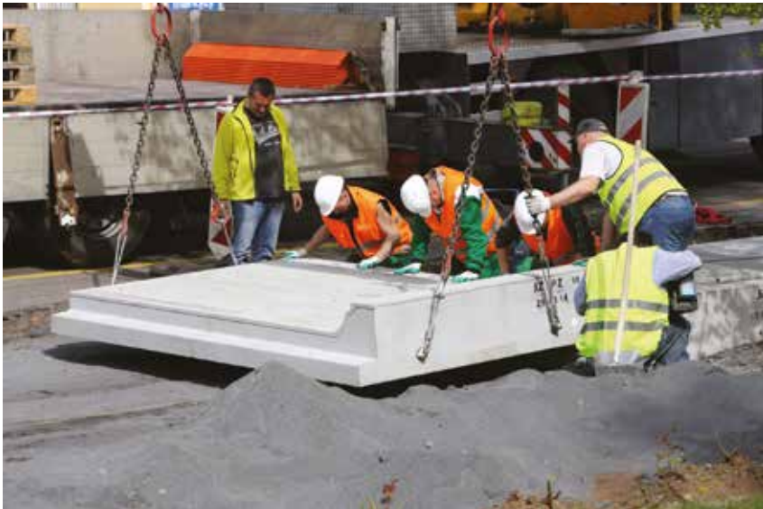
Jednotlivé panely jsou usazeny pomocí jeřábu. K jejich přesnému umístění slouží speciální naváděcí trny
