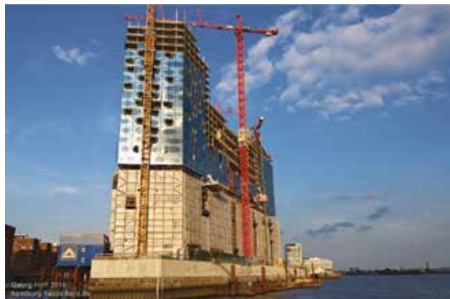
Vznikající skleněná fasáda Labské filharmonie, 2010
