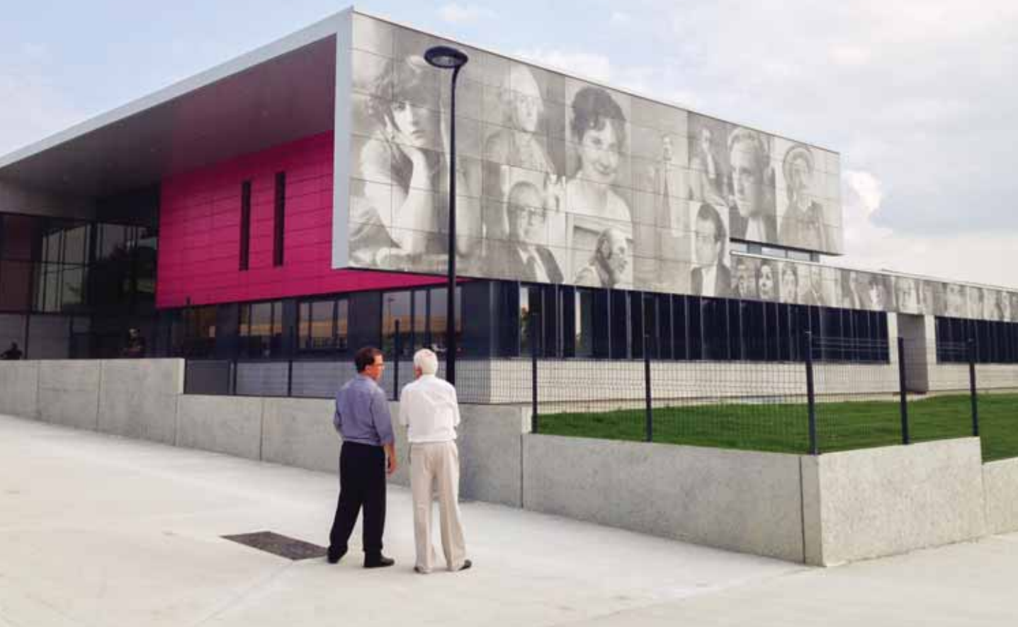
Fasáda školní budovy (350 m 2 ), Crevin, Francie, 2014, foto: archiv Graphic Concrete
