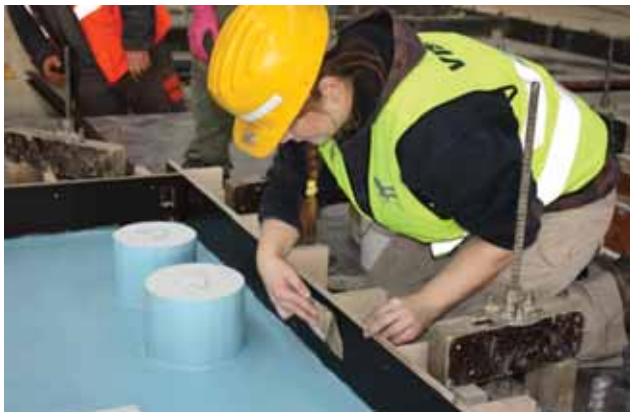
Zuzana Čížková nanáší hlinu na obvodní strany dřevěného bednění – druhého dílu pomníku přímo v betonáře v Dywidag Prefa v Lysé nad Labem
