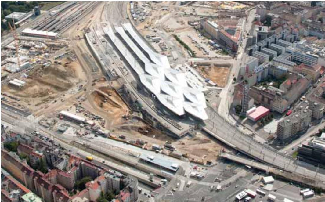
Pohled na již zastřešenou železniční stanici z ptačí perspektivy
