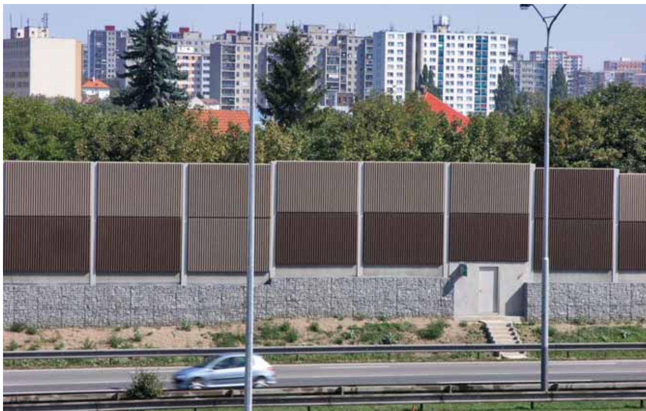
Protihluková stěna Liadur u pražského Chodova
