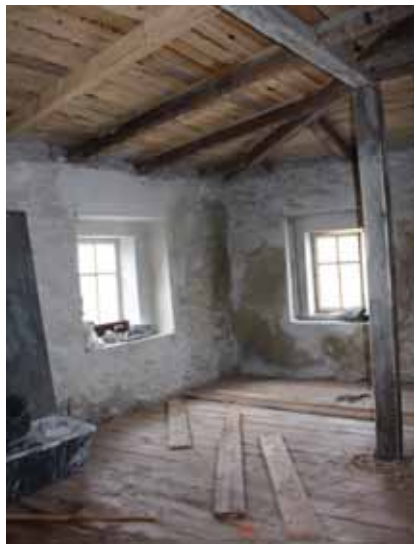
Snímek rekonstruovaného objektu OPS Milešovka
