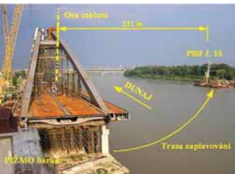
Princip montáže hlavního pole – pohled po proudu
