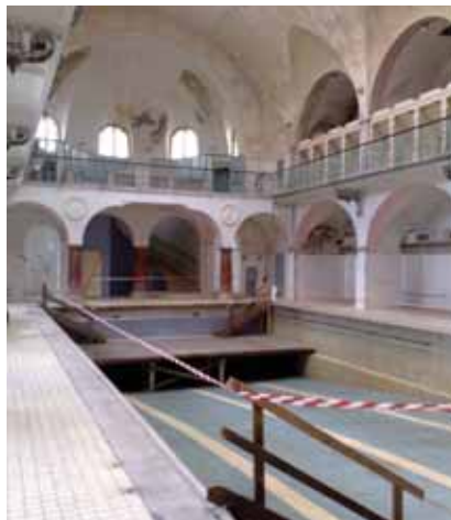
Fotografie vanových lázní v průběhu rekonstrukce
