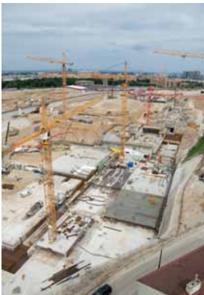
Betonářské práce při stavbě železniční stanice
