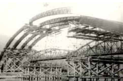
Armokoše systému B pro oblouk mostu v Praze Zbraslavi (1964)
