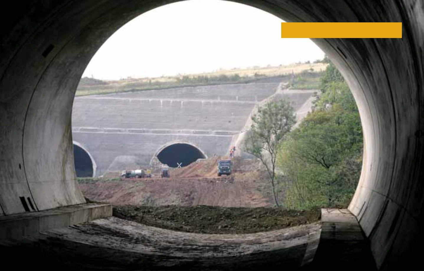
Pohled z PTT tunelu Prackovice na tunel Radejčín
