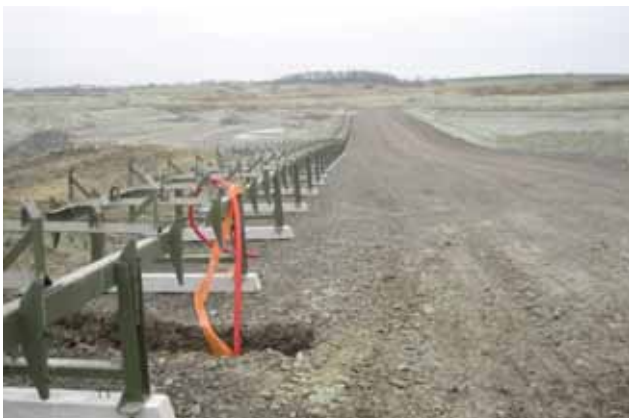
Snímek z výstavby pásového dopravníku
