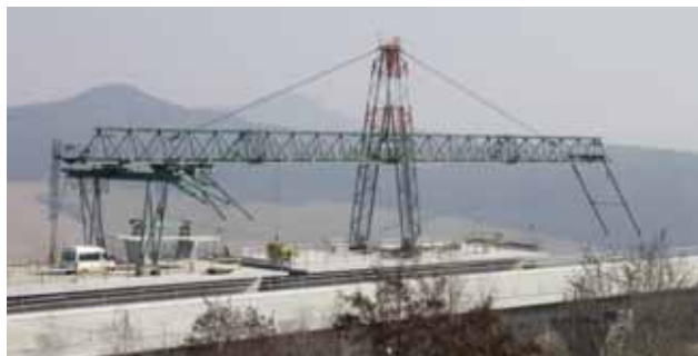
Snímek ze stavby na jaře roku 2012
