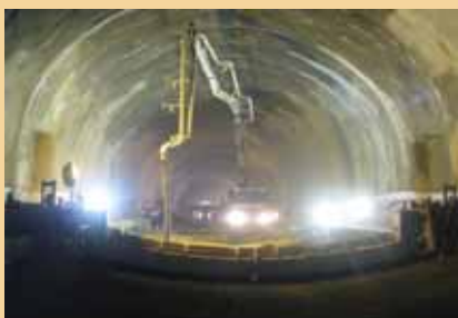
Betonáž spodní klenby ražené části tunelu Radejčín
