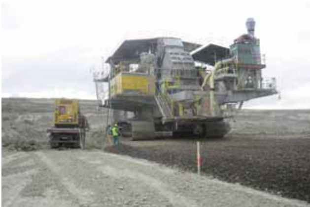
Spolu s drtírnou se pohybovala elektrocentrála, která zajišťovala napájení elektrinou
