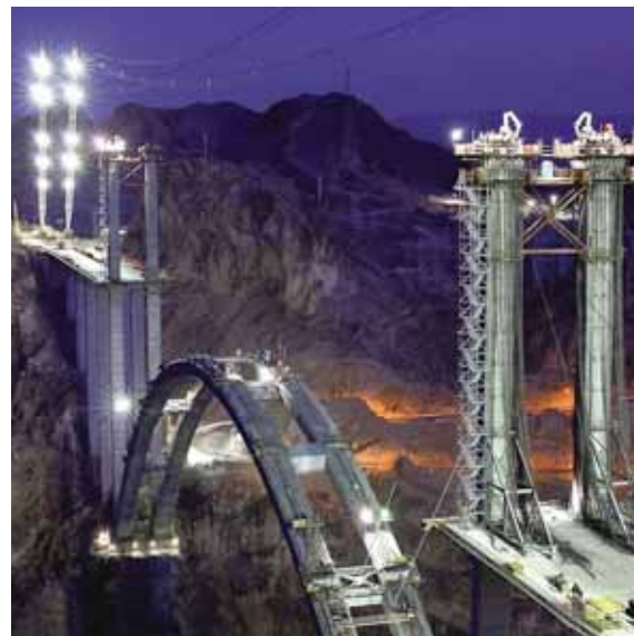
Dokončený oblouk mostu
