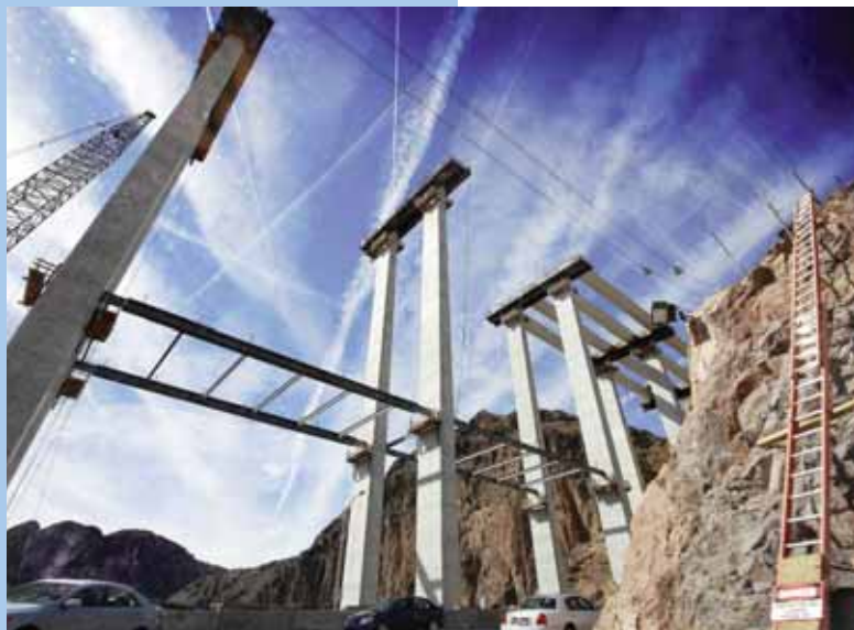
Pilíře a mostovky nevadského předpolí
