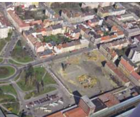
Letecký snímek ze stavby dopravního terminálu v Chebu
