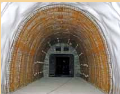
Armatura horní klenby propojky tunelu Radejčín
