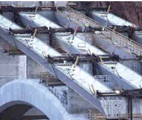
Ocelové nosníky mostovky
