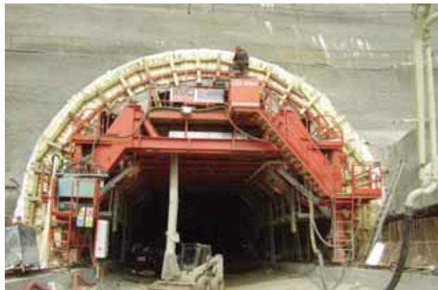
Betonáž bloku LT10
