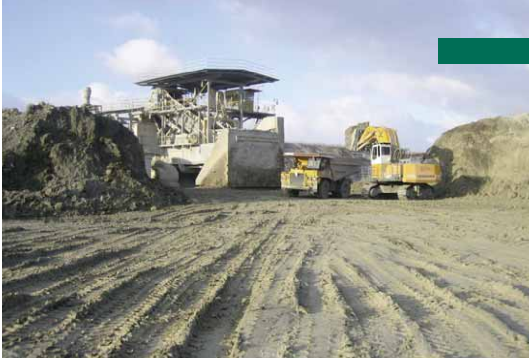
Záběr drtiče v původním prostoru v lomu po odtěžení nájezdové rampy před zahájením vlastního přesunu do nového prostoru
