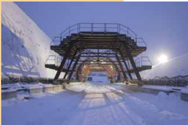
Železářská plošina, ocelové formy na ústeckém portálu tunelu Radejčín
