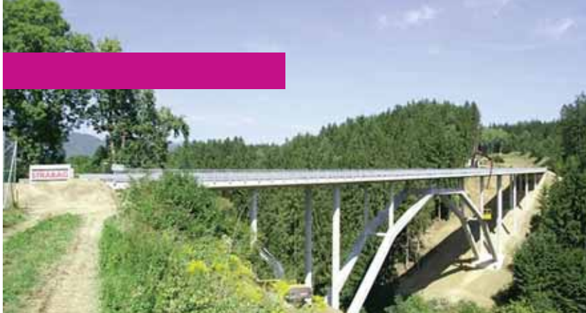
Most Völkermarkt z vysokopevnostního betonu (www.wild.raum.at)
