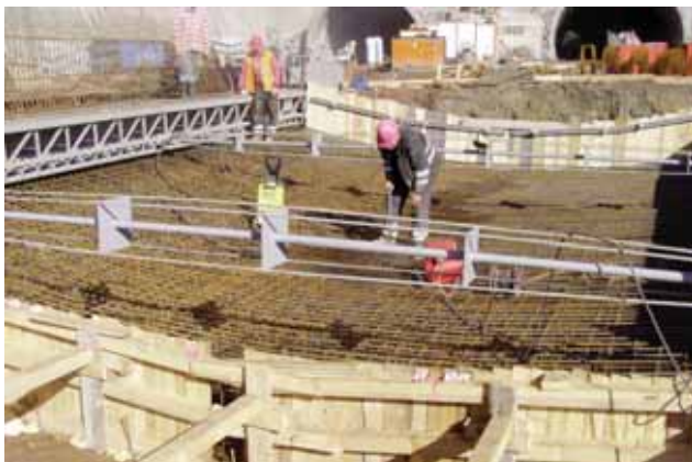
Příprava na betonáž bloku PT01
