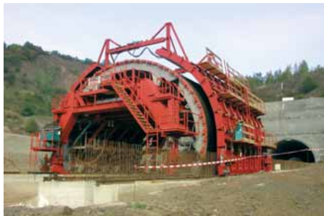
Ocelové pojízdné bednění
