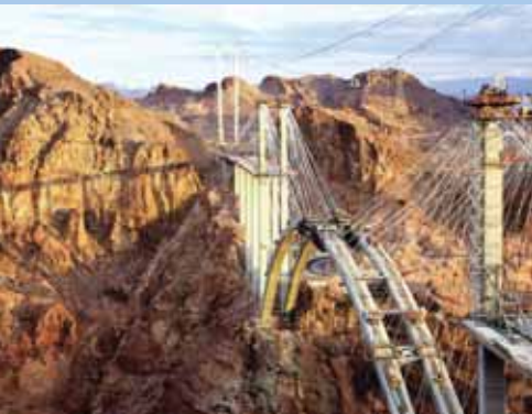
Zavěšení oblouku před uzavřením ve vrcholu
