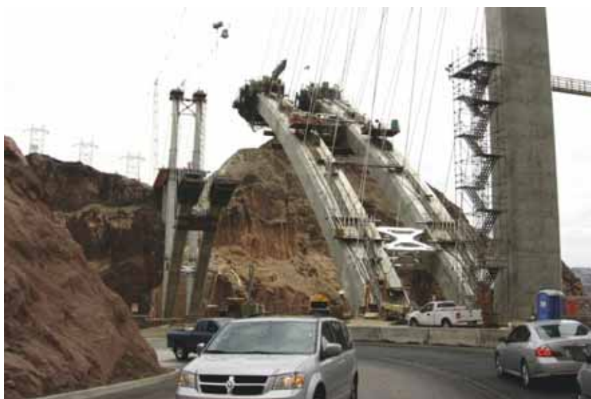
Výstavba oblouku mostu
