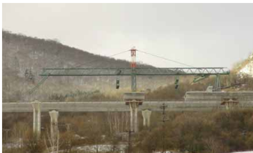
Na stavbě estakády byla použita segmentová technologie, která byla prověřena několikrát v praxi
