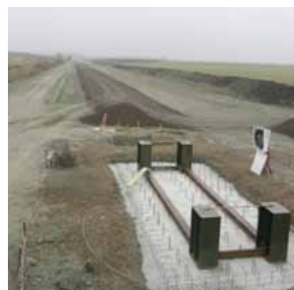
Dole: Snímek betonáže pro přesýpací stanici pásového dopravníku
