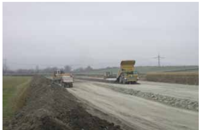
Stavba nové trasy pásového dopravníku do cementárny
