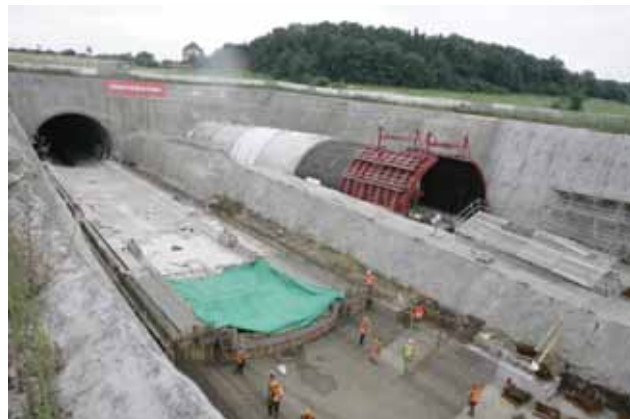
Výstavba hloubené části ústeckého portálu tunelu Radejčín
