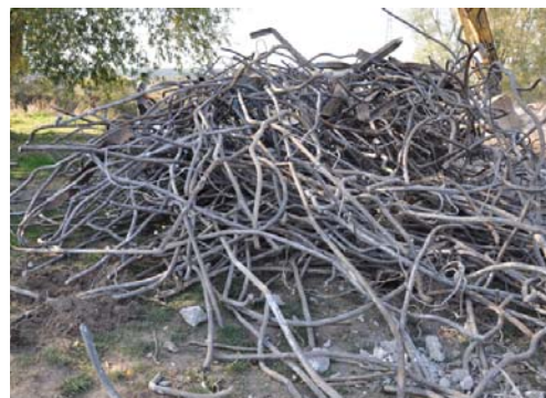
Vybouraná výztuž trámů
