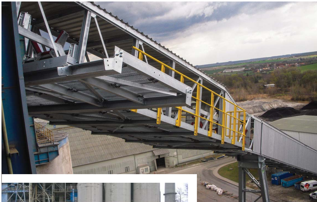
Zasunutí poslední části konstrukce Beumer pro U pás
