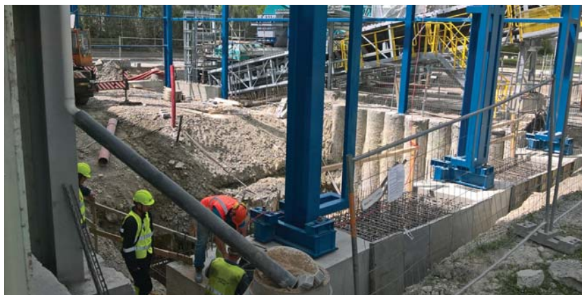
Průhled z budované přístavby haly na provizorní technologii vzadu, která byla zatím v provozu (BRU Schenck – Schenck váha – U pás Beumer)
