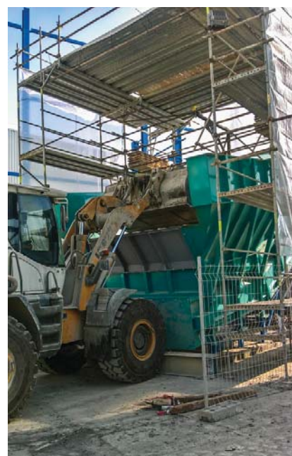
Provizorní plnění LC nakladačem do jednotky BRU Schenck – hala ještě zdaleka nebyla hotova
