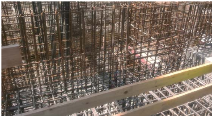
Armování podzemních zásobníků firmou Raeder & Falge
