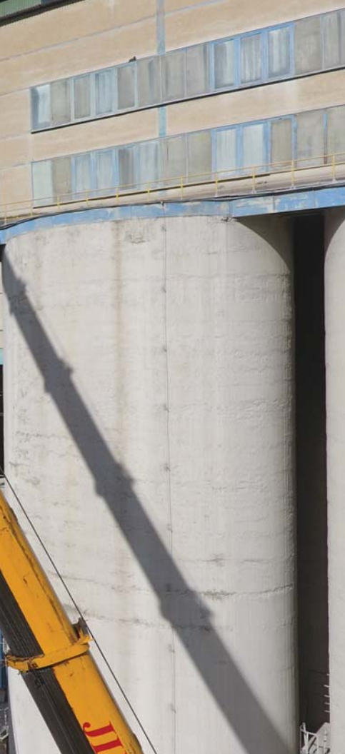
Montáž konstrukce U pasu Beumer s pomocí jeřábů firmy Jiránek
