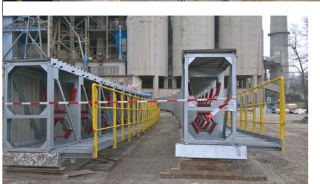
Začátek stavby U pásu Beumer – připravené jednotlivé úseky
