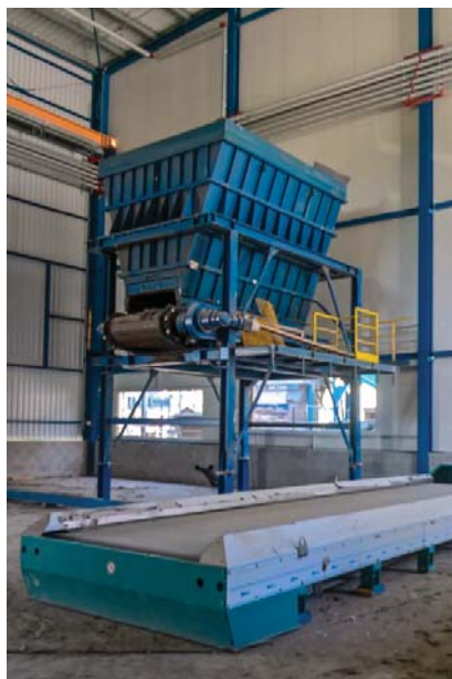
Přesunutý původní zásobník drcené štěpky již na novém místě v přístavbě
