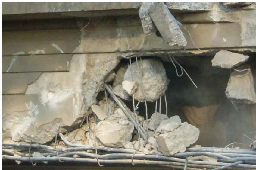
Detail výztuže při bourání
