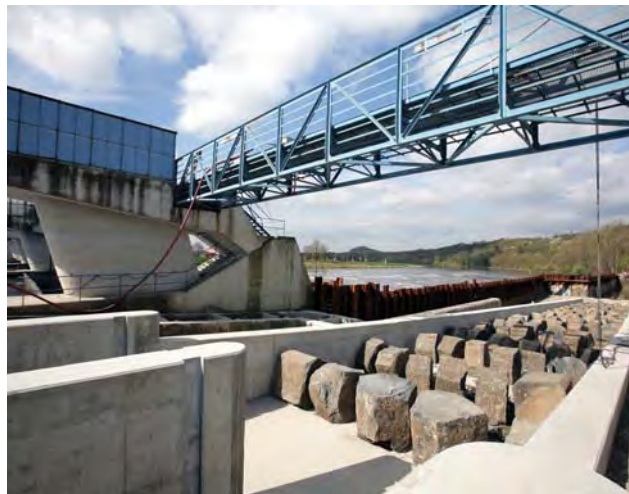
Výstavba rybích přechodů
