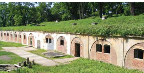
Pevnost Fort VII Lętownia
