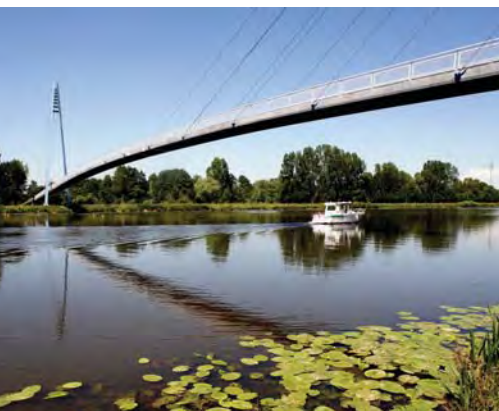
Obr. 6 Pohled na hotový most
