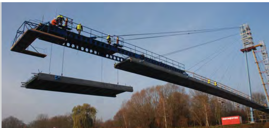
Obr. 3 Montáž segmentové NK
