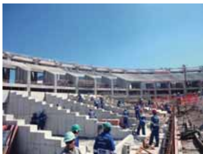
Obr. 6 Monolitická dolní část nové tribuny
