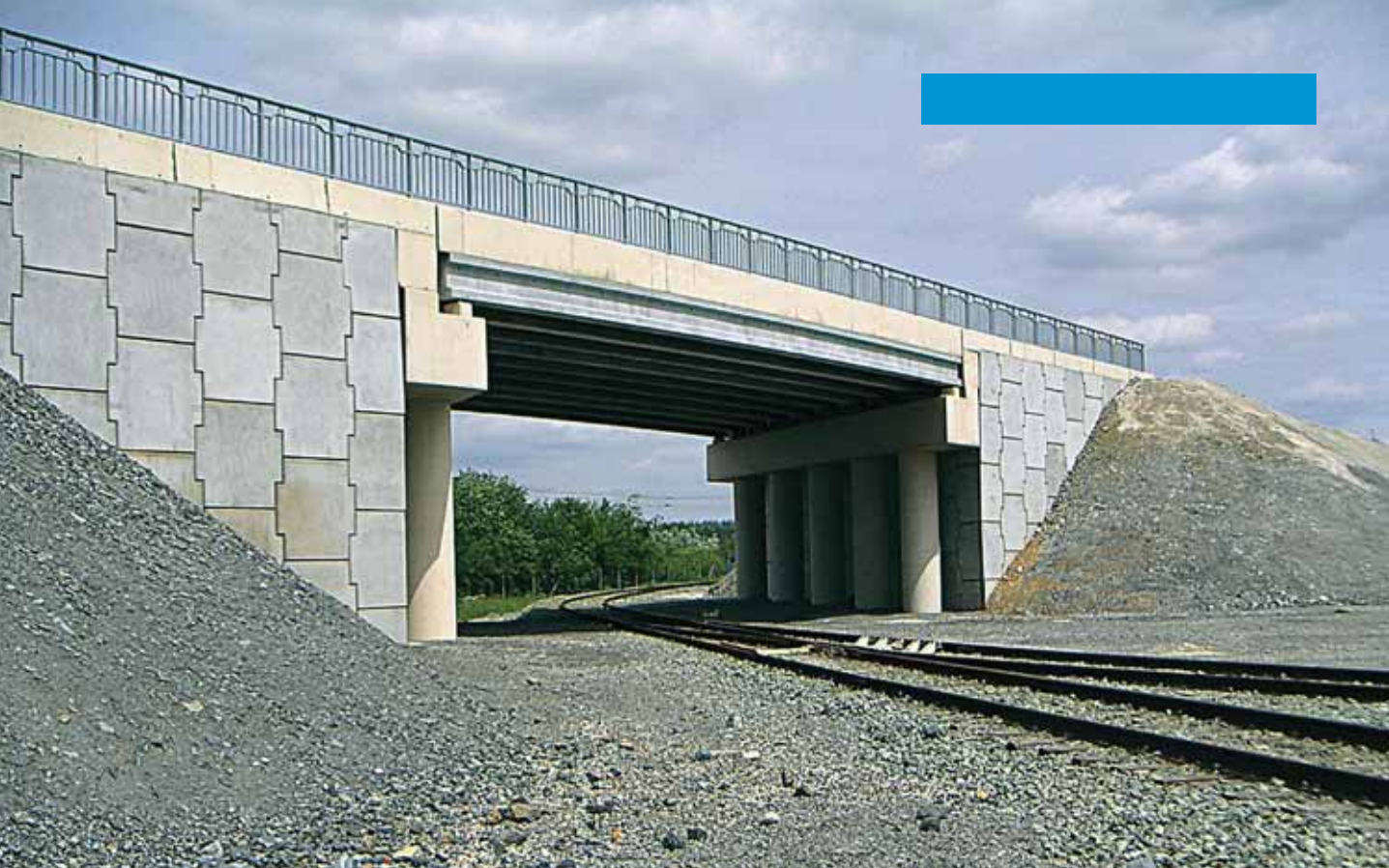
Uspořádání mostu – pohled na hotový most
