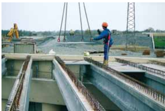
Osazené nosníky Ductal® a montáž desek Ductal® ztraceného bednění
