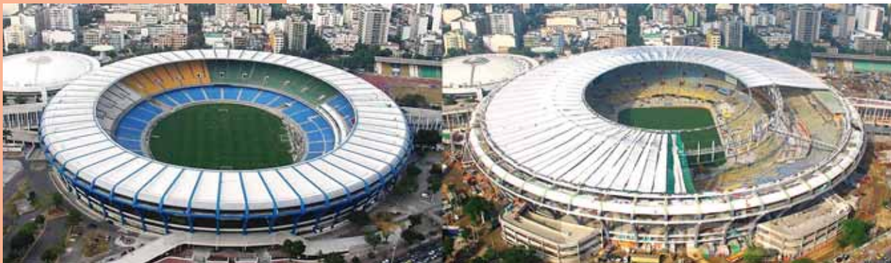
Obr. 1 Letecký pohled na původní a novou Maracanã
