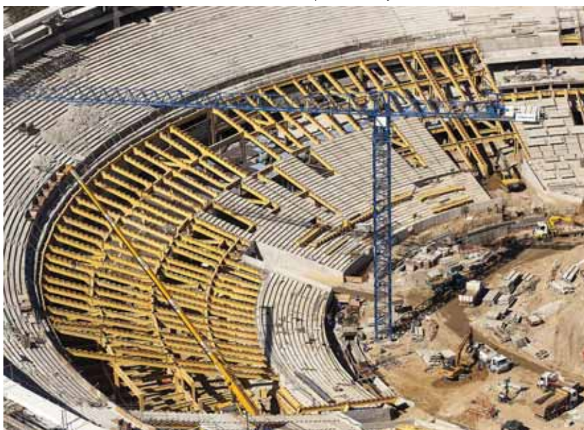
Obr. 7 Výstavba nové ocelobetonové střední části nové tribuny
