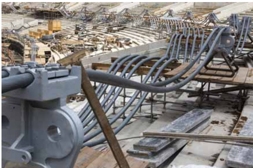
Obr. 9 Systém lan podpírajících konstrukci zastřešení
