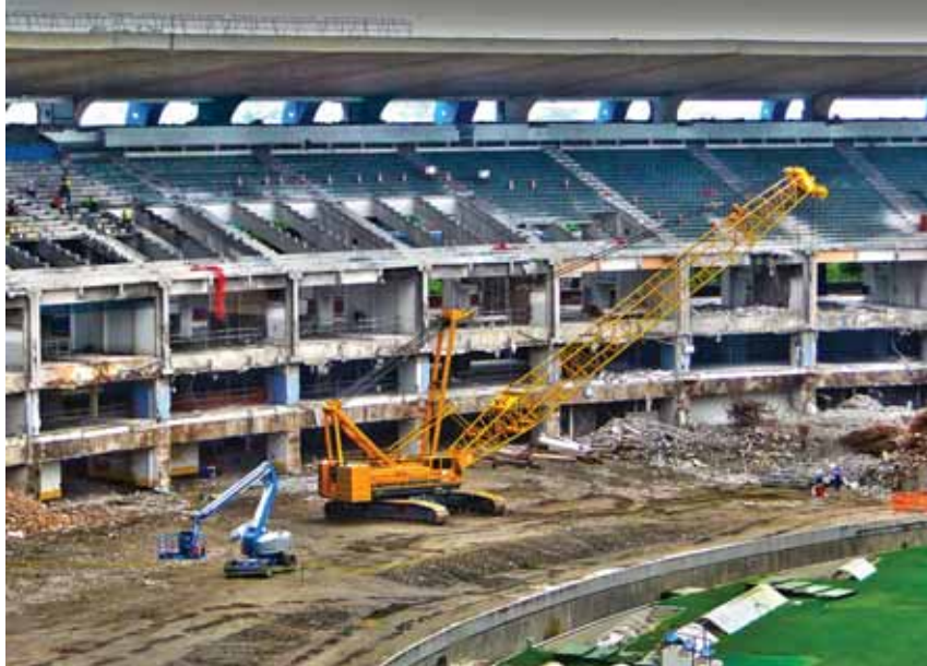
Obr. 5 Demolice původní spodní tribuny stadionu
