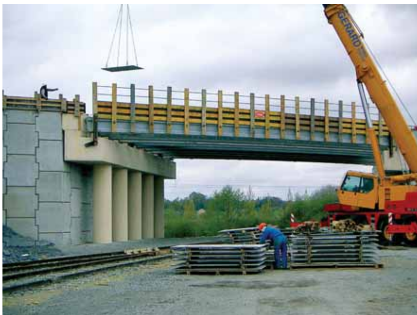
Příprava pro betonování desky mostovky. Montáž desek Ductal® ztraceného bednění.
