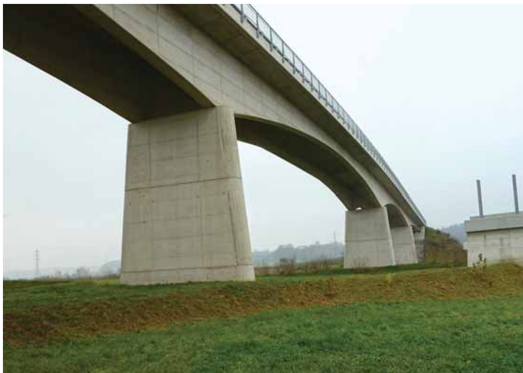
Mostní konstrukce pro koralmskou železnici
