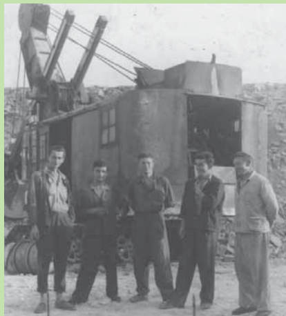
Na fotografii z roku 1957 je vidět staré rypadlo, které pracovalo ještě v lomu II
