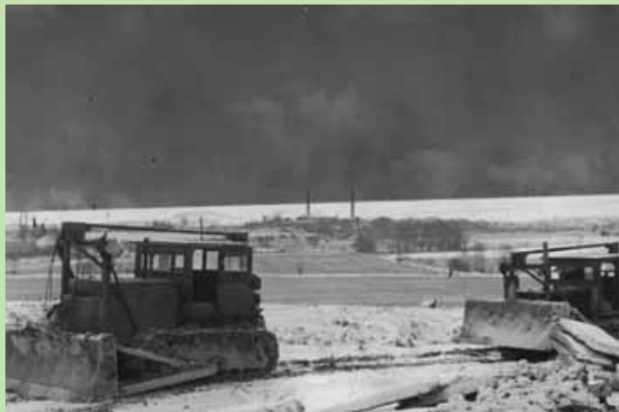
Foto ze zimy roku 1960, v pozadí starý závod, v popředí lanové buldozery
