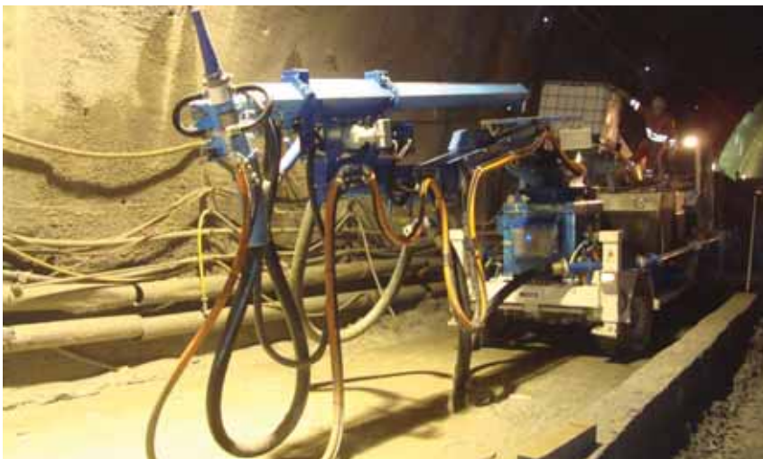
Snímek ze stavby Koralmského železničního tunelu
