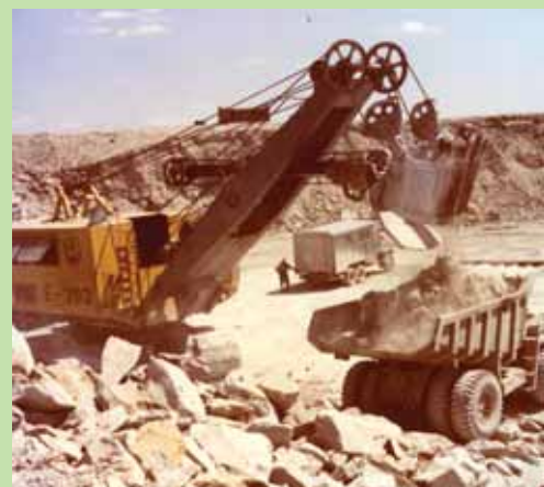
Novější elektrické rýpadlo E 303, nákladní automobil Belaz
