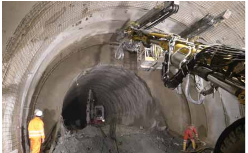
Montáž kotvení
