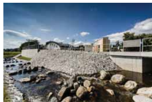
Rybí přechod byl podmínkou povolení ke stavbě MVE
