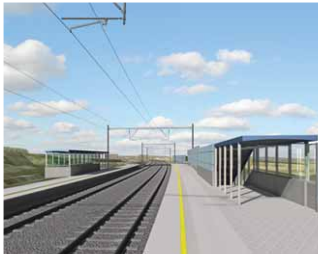
Železniční stanice Sudoměře u Tábora bude zrušena a v jejím místě bude vybudována nová železniční zastávka se dvěma vnějšími nástupišti. Přístup na nástupiště ulehčí cestujícím nové přístupové chodníky i nový podchod se schodištěm.
