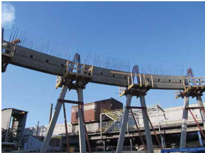
Plášť chladicí věže je založen na 26 párech šikmých sloupů, které jsou umístěny po obvodu základového prstence
