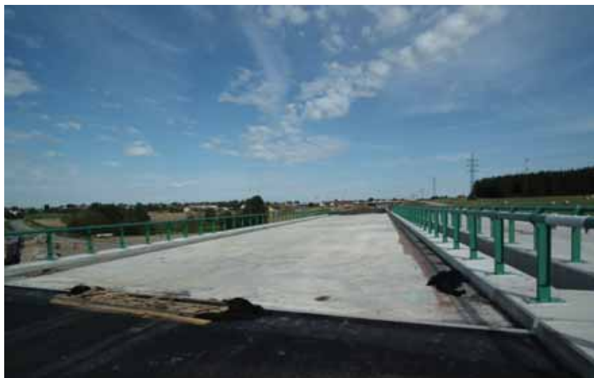
Pohled na mostovku 7-201, most v km 79,98 přes silnici III/4093 a výpust z retence
