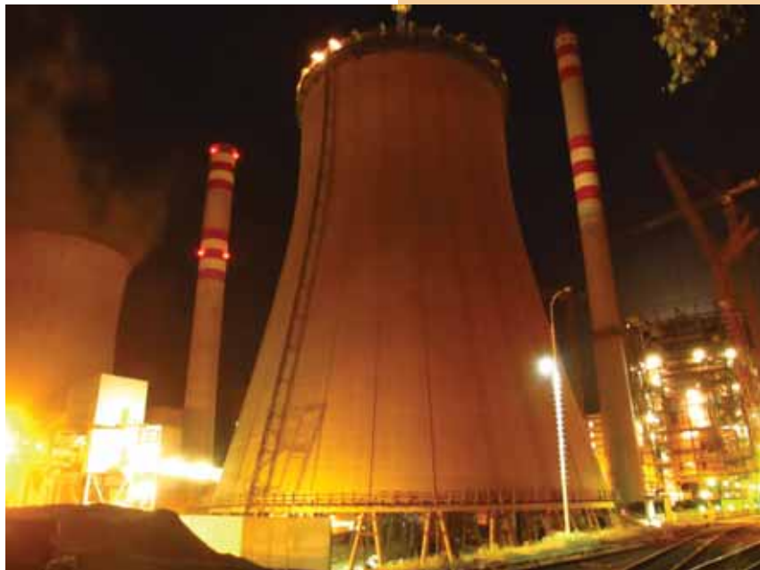
Energetický blok K7 se nachází v průmyslovém areálu bývalé Poldi Kladno
