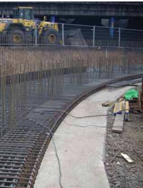
Základy věže tvoří betonový prstenc
