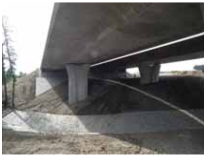
Pohled na přeložku vodoteče (SO 7-358) a most v km 79,980 přes silnici III/4093 a výpust z retence (SO 7-201)
