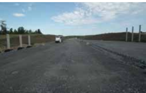
Dálnice D 3 v zářezu mezi mostem přes Kožský potok (SO 7-202) a mostem přes výpust rybníka Jezero (SO 7-204)
