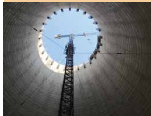
Detailní snímek věžního pláště z července 2012
