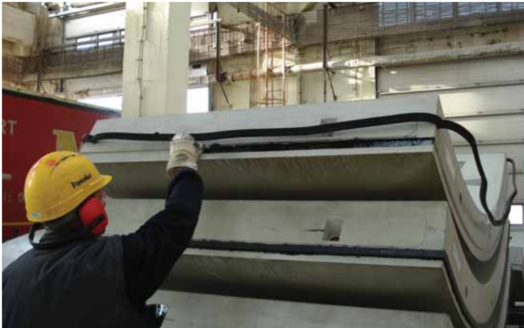
Obr. 6 Lepení těsnění
