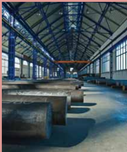
Pohled do původní haly „staré lisovny“ rekonstruované na expediční halu
