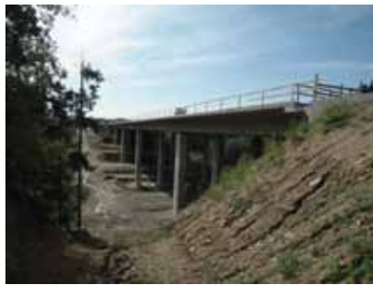
Most (SO 7-202) přes údolí Kožského potoka v km 80,319
