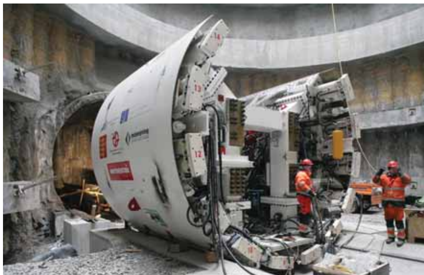
Obr. 3 Montáž TBM ve startovací jámě na Vypichu
