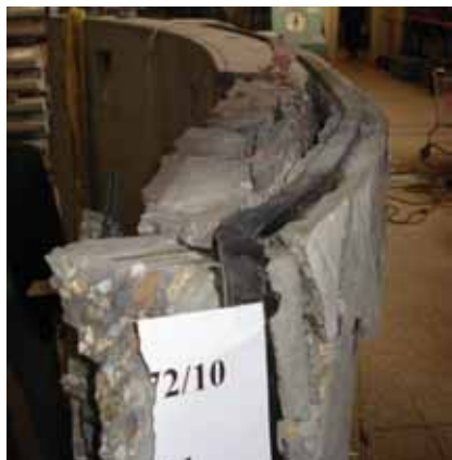
Obr. 7 Tlakem porušený železobetonový segment
