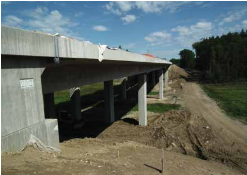
Most přes výpust rybníka Starý Kravín (SO 7-206) a biokoridor v km 80,13
